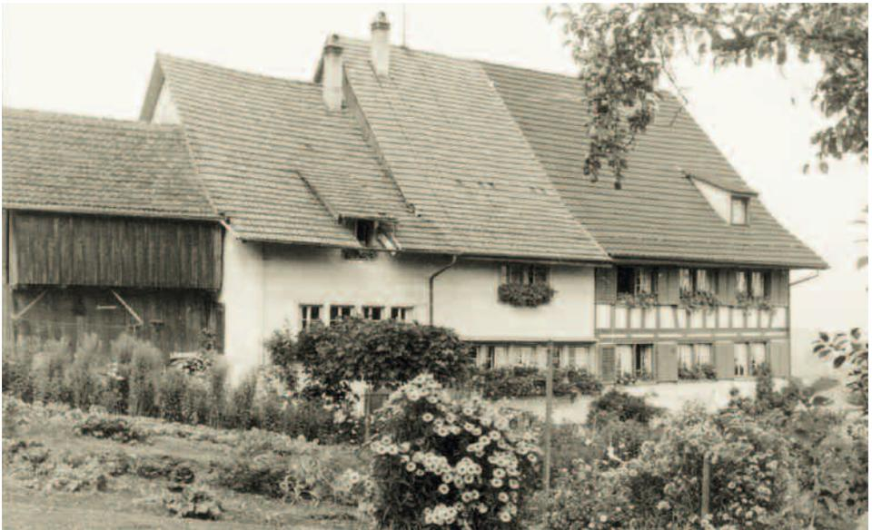
*1948: Hier gut sichtbar, der noch nicht angehobene ursprüngliche Dachstock im obersten, westlichen Hausteil, der auf Grund der Dachneigung als ältester Teil angesehen wird.*
