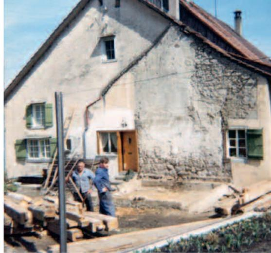
*Nach dem Abbruch des östlichen Anbaues wurde das einstige Mauerwerk gut sichtbar: kein Riegelbau.*
